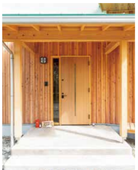
すっきりと広い玄関ポーチ。日本の伝統工法を用いた、垂木張りの屋根と、下見板張りの壁が、印象的な表情を創り出している。
